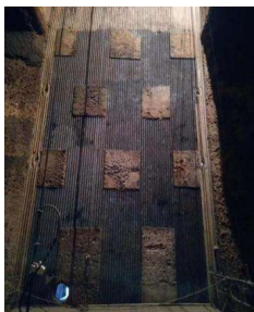
图 4 卫燃带面积以及其敷设方式优化改造
