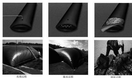
图1 土工管袋脱水技术
