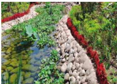
草堂营村污水处理站生态缓冲带
