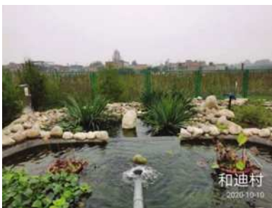
和迪村污水处理站生态缓冲带
