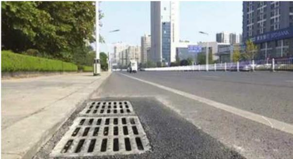
图2 路面排水口设置
