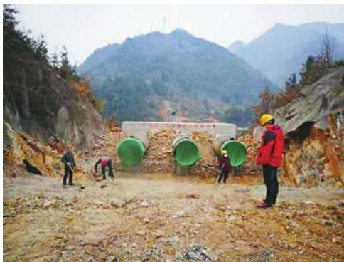
水利工程施工现场
