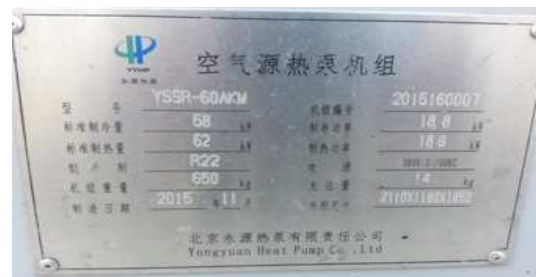
图 3 空气源热泵铭牌
