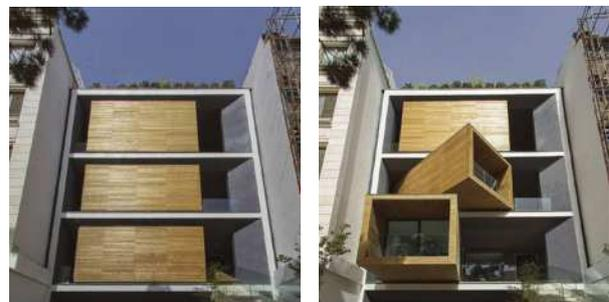
图1 动态建筑(起初状态) 图2 动态建筑(旋转状态)
