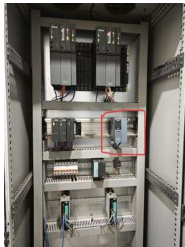
图 3 升级为 PROFINET PN 网络硬件改造图（采用路径二不拆除和更换原有模块，只增加一个 1500CPU 和 1500 通讯模块即可）
