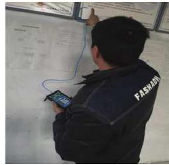
无线路由器下行端口测速达标，设备性能满足要求，符合千兆宽带指标标准
