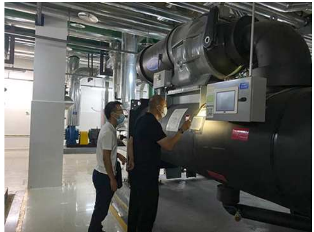
图2 氨制冷压力容器检验处理
