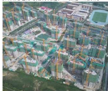
图 1 某装配式建筑工程
