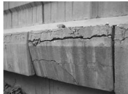
图1 水利工程混凝土裂缝
