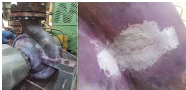
图三 焊接照片
