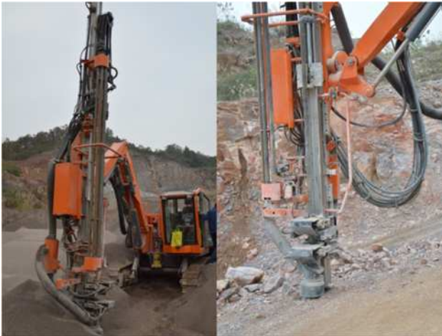
图 10 现场施工作业
