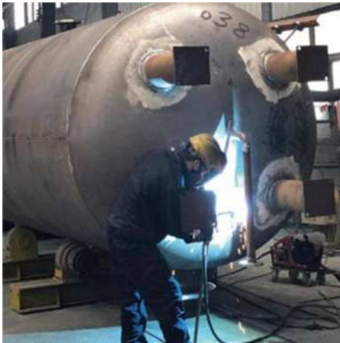
图1 压力容器焊接施工
