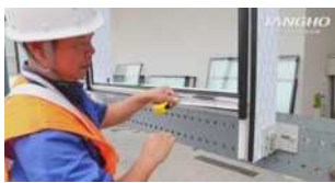
图5 玻璃托板安装
