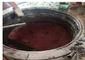
图 13 拆除土砂密封
