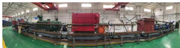
装配现场的煤层加砂压裂泵组
