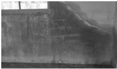
图1 外墙渗漏
