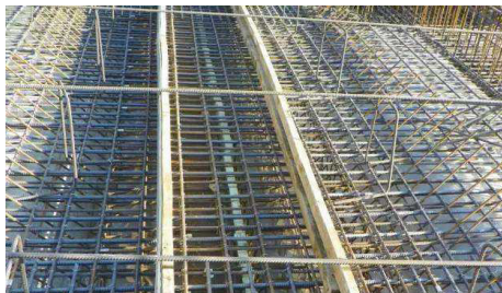
图2 后浇带钢筋绑扎图
