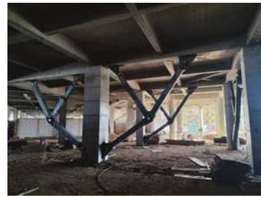
图 2 减震阻尼器现场安装效果图
