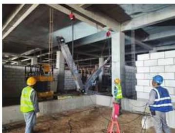
图8 阻尼器钢支撑整体安装
