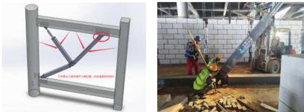
图7 阻尼器吊耳及钢支撑整体组装
