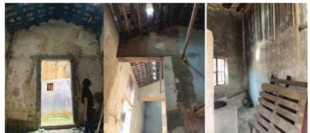
图4 传统建筑实景
