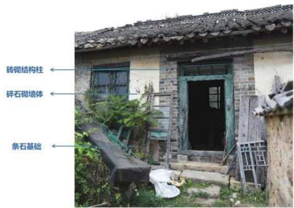
图2 房屋结构示意图
