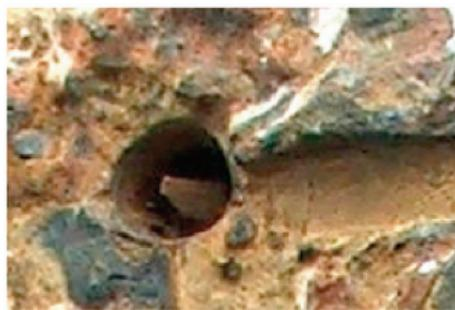
图8.在潮汐条件下暴露于海水85年后，直径为32 mm的钢筋残骸的端视图，开裂的混凝土横截面上有水状锈迹（照片由克莱顿·史密斯提供）。
