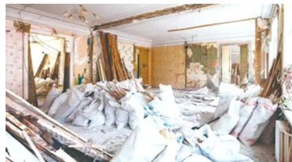
图1 施工现场废料随意丢弃
