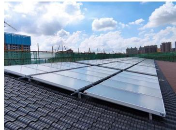
图2 太阳能集热板安装效果
