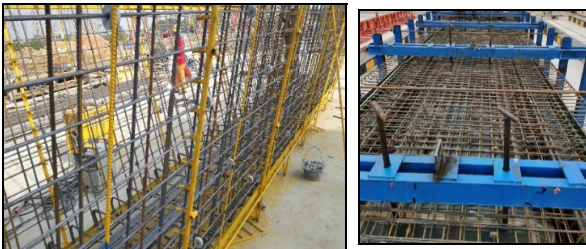
钢筋保护层垫块及钢筋压杠示意图
