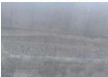
图 3.9 两次浇筑施工缝明显且有色差
