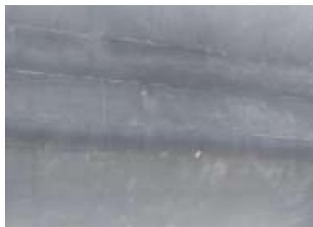
图 3.10 一次浇筑无施工缝及色差不明显
