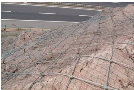
图1 路基边坡挂网防护
