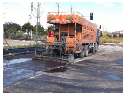
图 1 稀浆封层现场施工图
