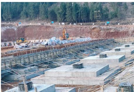
图4 隔震支座预埋定位图
