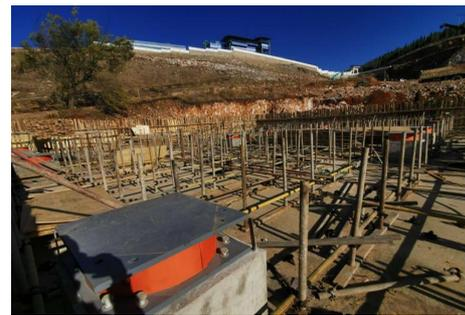
图5 隔震支座安装图
