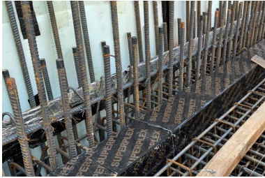
图2 钢板橡胶腻子止水带施工示例
