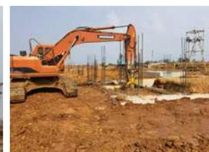
图2 基础周边回填土夯实
