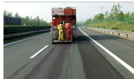
图2 沥青路面施工
