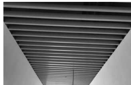
图 3.6-1 铝方通安装后效果
