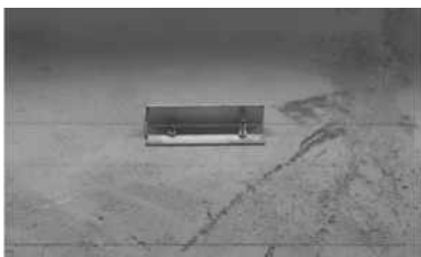
图 3.4-1 固定角铁安装
