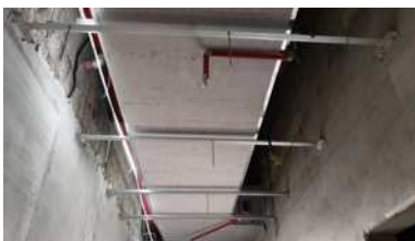
图 3.4-2 对撑角钢安装
