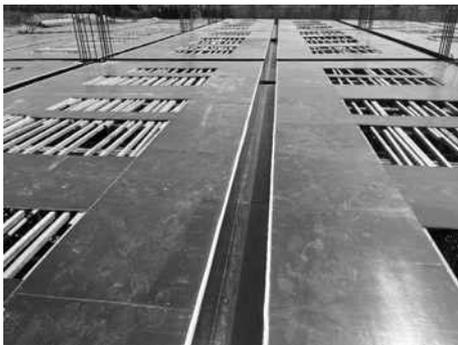
图1 叠合板支撑体系施工图
