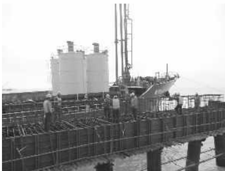
图1 高桩码头施工现场图
