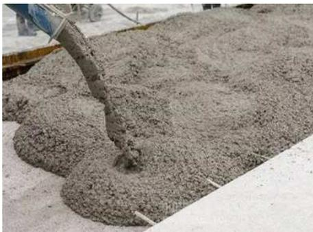
图 2: 钢纤维混凝土桥面铺装
