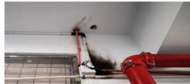
图四: 线路布置不合理(插座位于引水管下方, 导致短路)。
