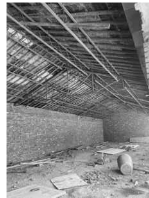
图4 南村自建房现场照片
