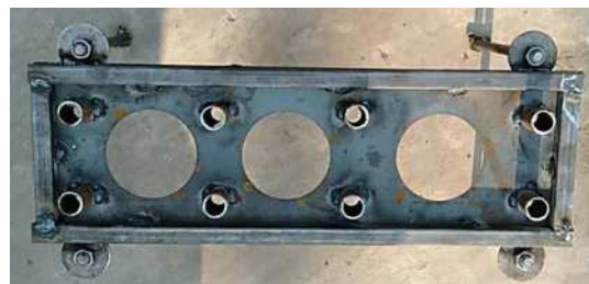
图3 定位措施筋示意图
