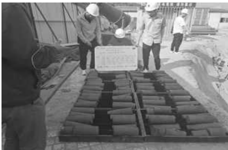
照片2 抽芯取样
