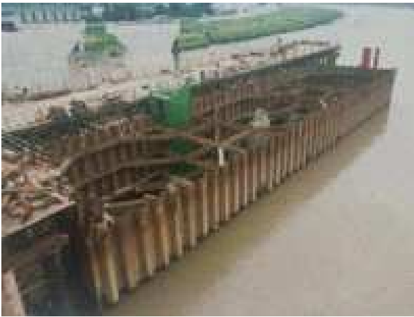
图1 钢板桩围堰
