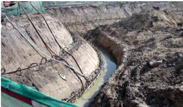
图 2 基坑降水施工
