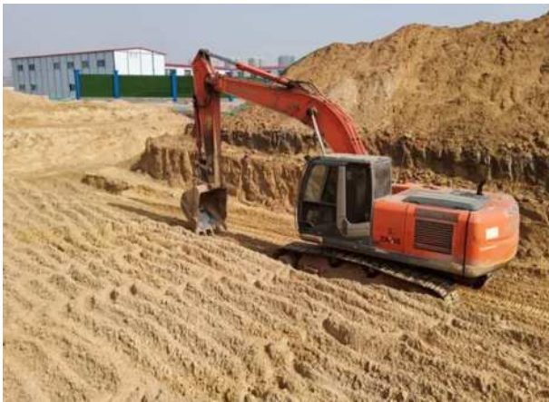
图1 土方开挖施工
