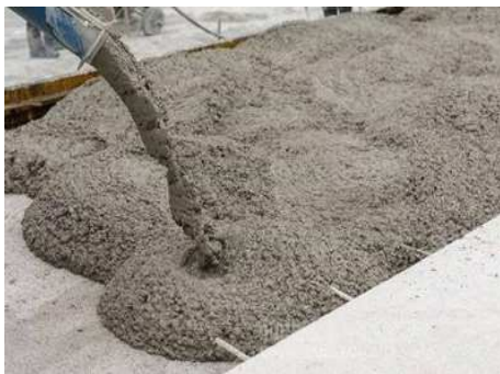
图 2: 钢纤维混凝土桥面铺装
