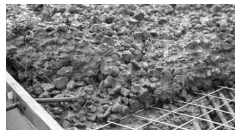
图1: 钢纤维混凝土
