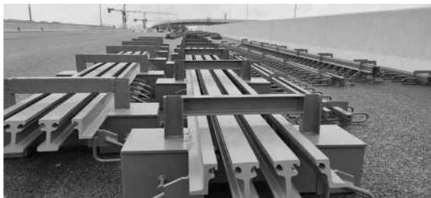
图1 桥梁伸缩缝
