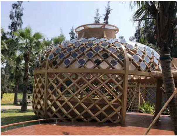
图1 博鳌某项目椰林部落景观构筑物实景图
