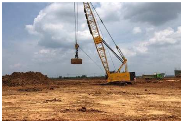
图 2 地基置换法施工现场
