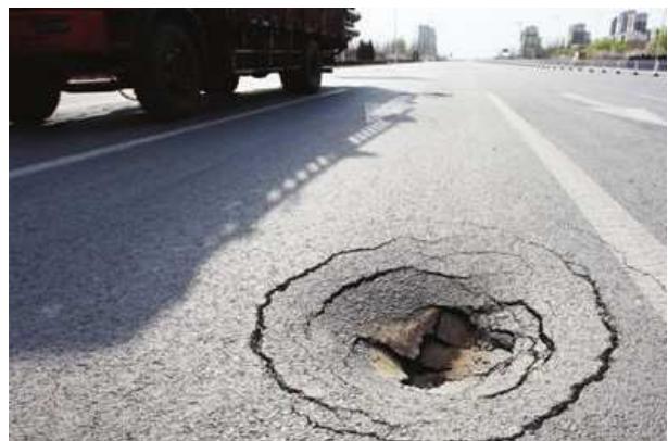
图1 公路工程路面塌陷示意图
