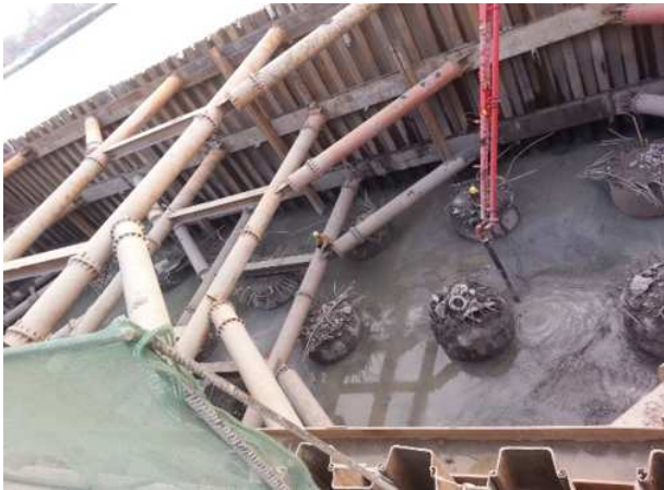
图 11 围堰底部浇灌混凝土实物图
