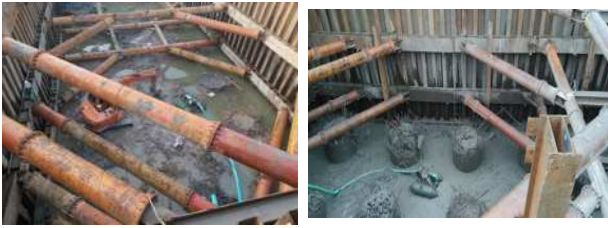
图 10 围堰底部清淤、抽水排淤实物图
