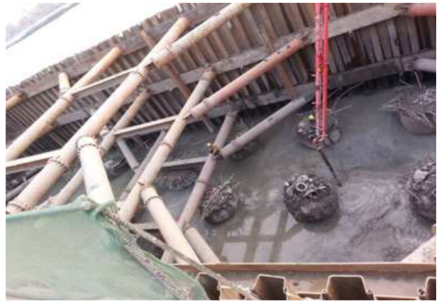
图 5 围堰底部打桩后的实物图
