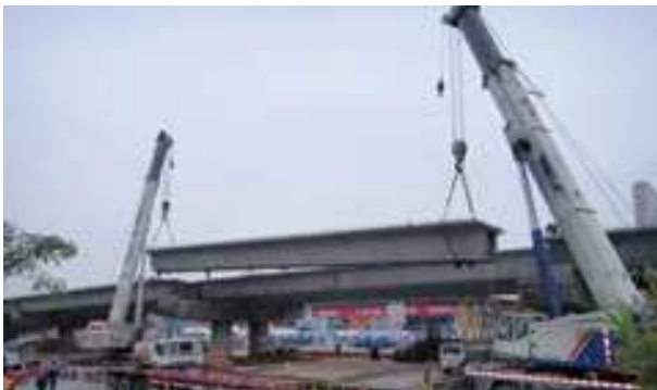
图2 节段梁预制拼装及预制小箱梁吊装示意图
